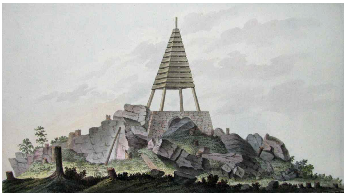
Nákres signalizace a stabilizace bodu vojenské triangulace - Schönningerberg v tehdejším Budějovickém kraji, (Triangulirung 1808)
